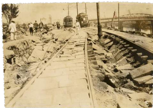
【図IV】新吉田川周辺の被災状況 日本電報通信社撮影
